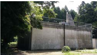
② 第2配水池
