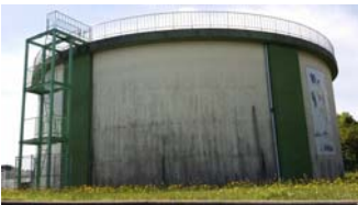
③ 第3配水池
