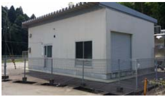
② 牛山送水ポンプ場
